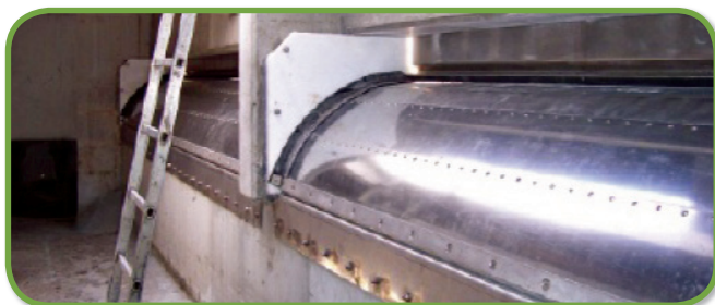
Bøjeklap med tilbagestuvningssikring (indløb-udløb-overløb)
