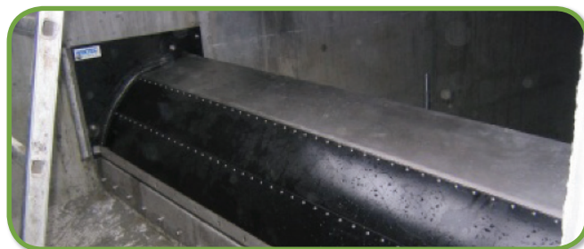
Bøjeklap uden tilbagestuvningssikring (indløb-udløb-overløb)
